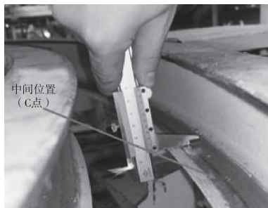
图12 轨道磨损测量法图示
