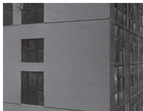
图 14 改造后的西立面外墙
