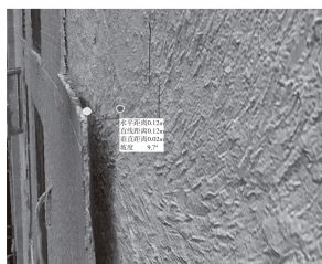
图 16 饰面砖脱开距离测量
