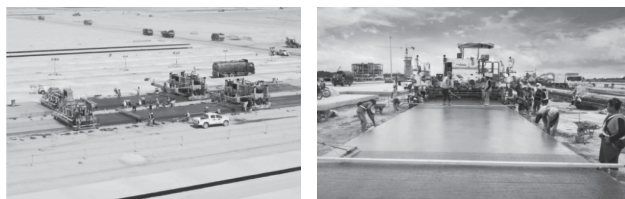
图1 滑模摊铺技术及其施工场景
