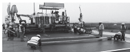
图1 滑模摊铺及其人工后处理
